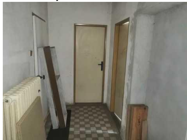
chodba v I.NP
