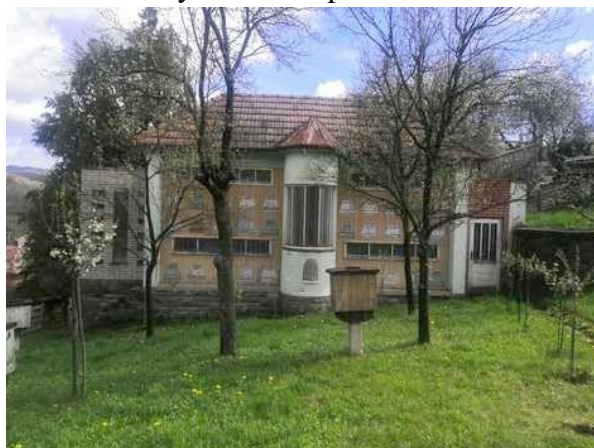
bývalý včelín na p.č.st.386
