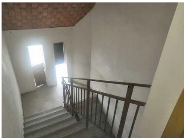
schodiště v RD na p.č.st.246
