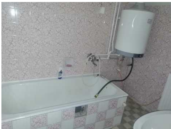
interiér II.NP vedl. stavby
