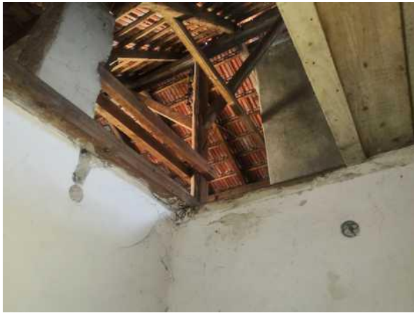
půdní prostor nad podkrovím
