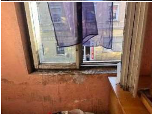
viditelné zatékání do BJ v úrovni 2.NP
