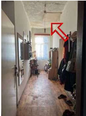
viditelné zatékání do BJ v úrovni 2.NP
