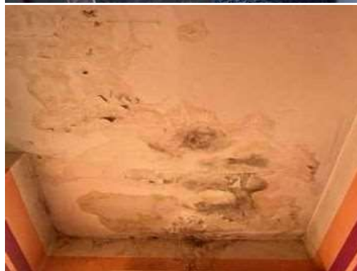
viditelné zatékání do BJ v úrovni 2.NP
