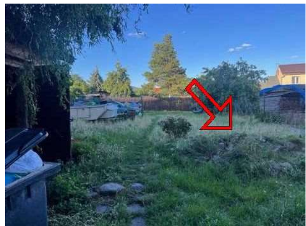
zbořeniště druhé hospodářské budovy
