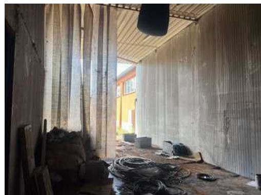
vnitřní prostor stavba na pozemku parc. č. 749/1
