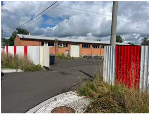
příjezd ke stavbě haly č. p. 63
