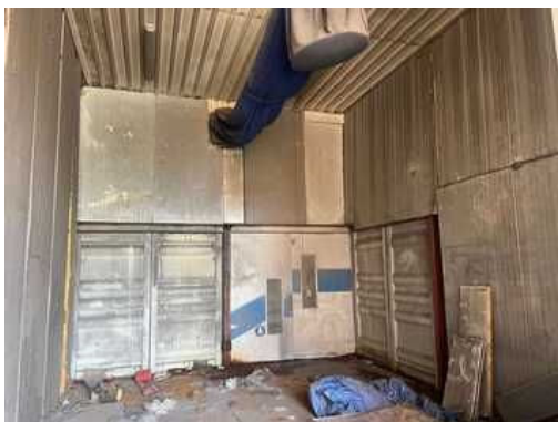
vnitřní prostor stavba na pozemku parc. č. 749/1
