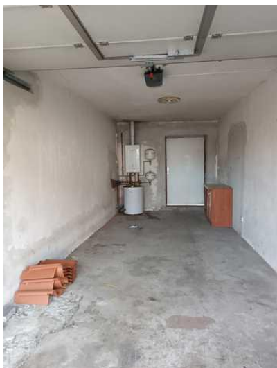
garáž v č.p.93
