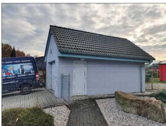
Garáž umístěná vedla RD se sedlovou střechou
