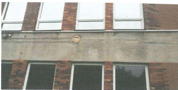
statické zajištění tyčemi helifix
