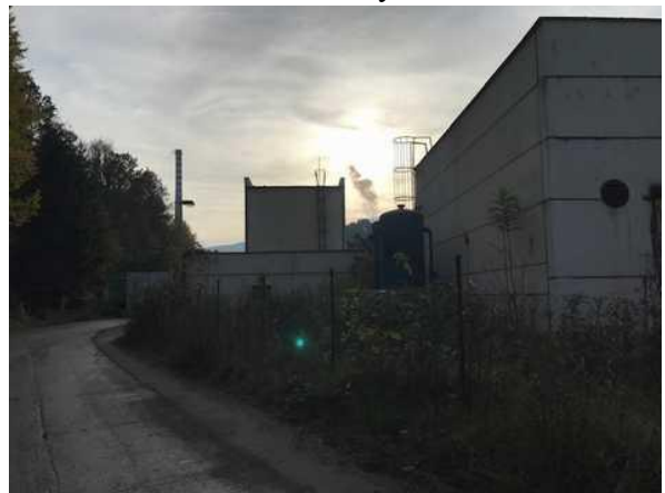
pohled na objekt
