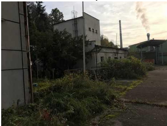
pohled na objekt
