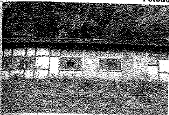
pohled na objekt
