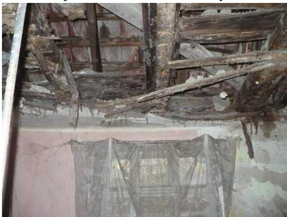
propadnuté stropy v části objektu
