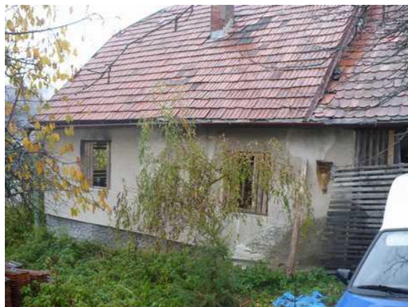
poškozená konstrukce krovu
