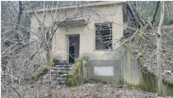
pohled na objekt
