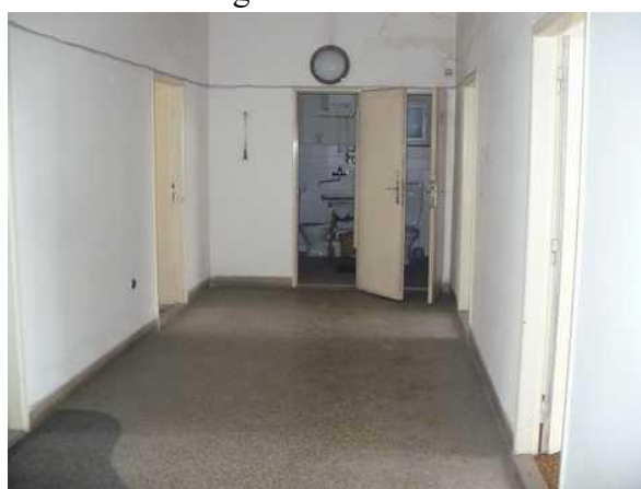
chodba sec. zařízením
