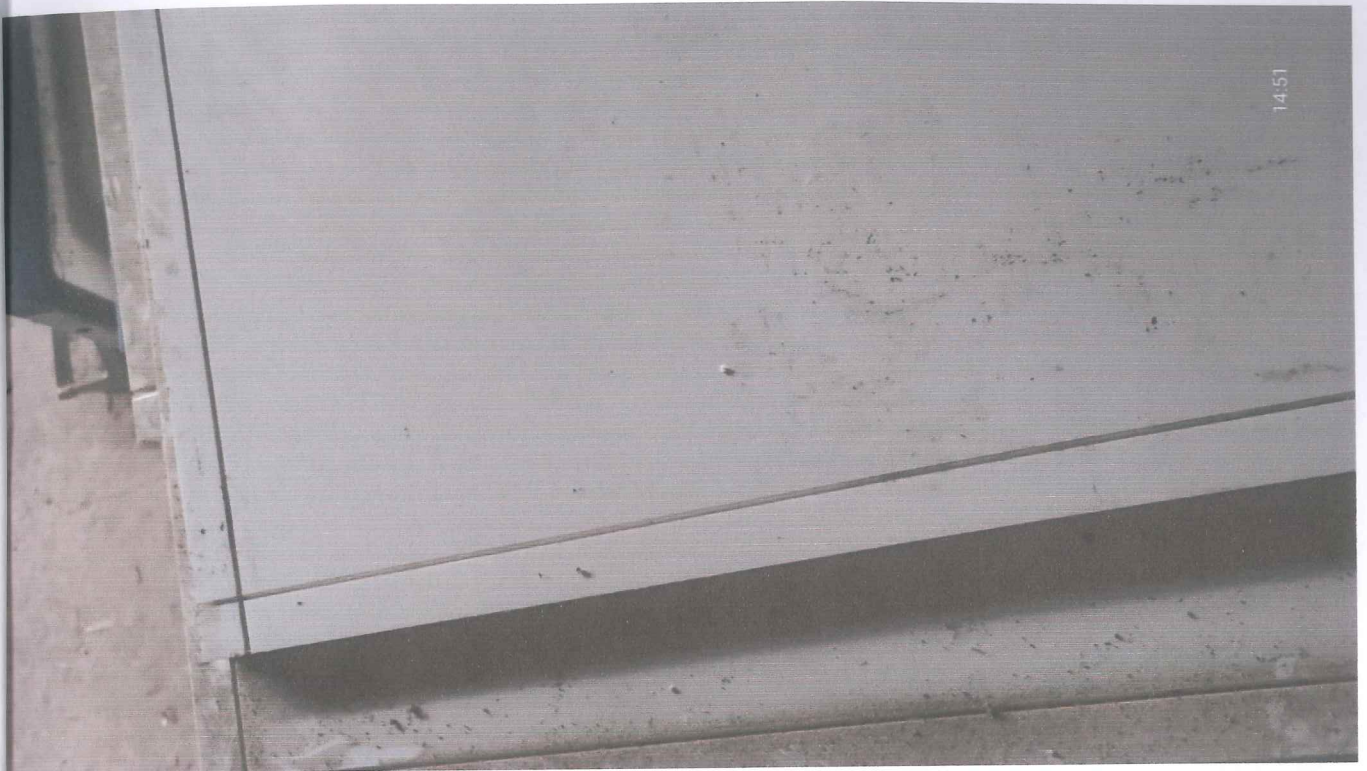
Panel ze spodní strany – drážky pro spojovací lišty, spojovací lišta
