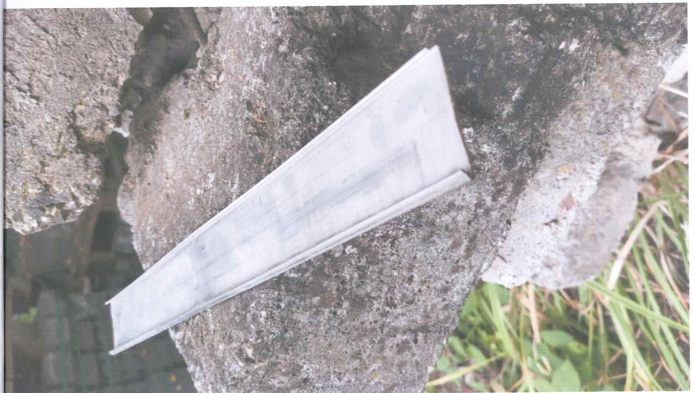
Panel ze spodní strany – drážky pro spojovací lišty, spojovací lišta
