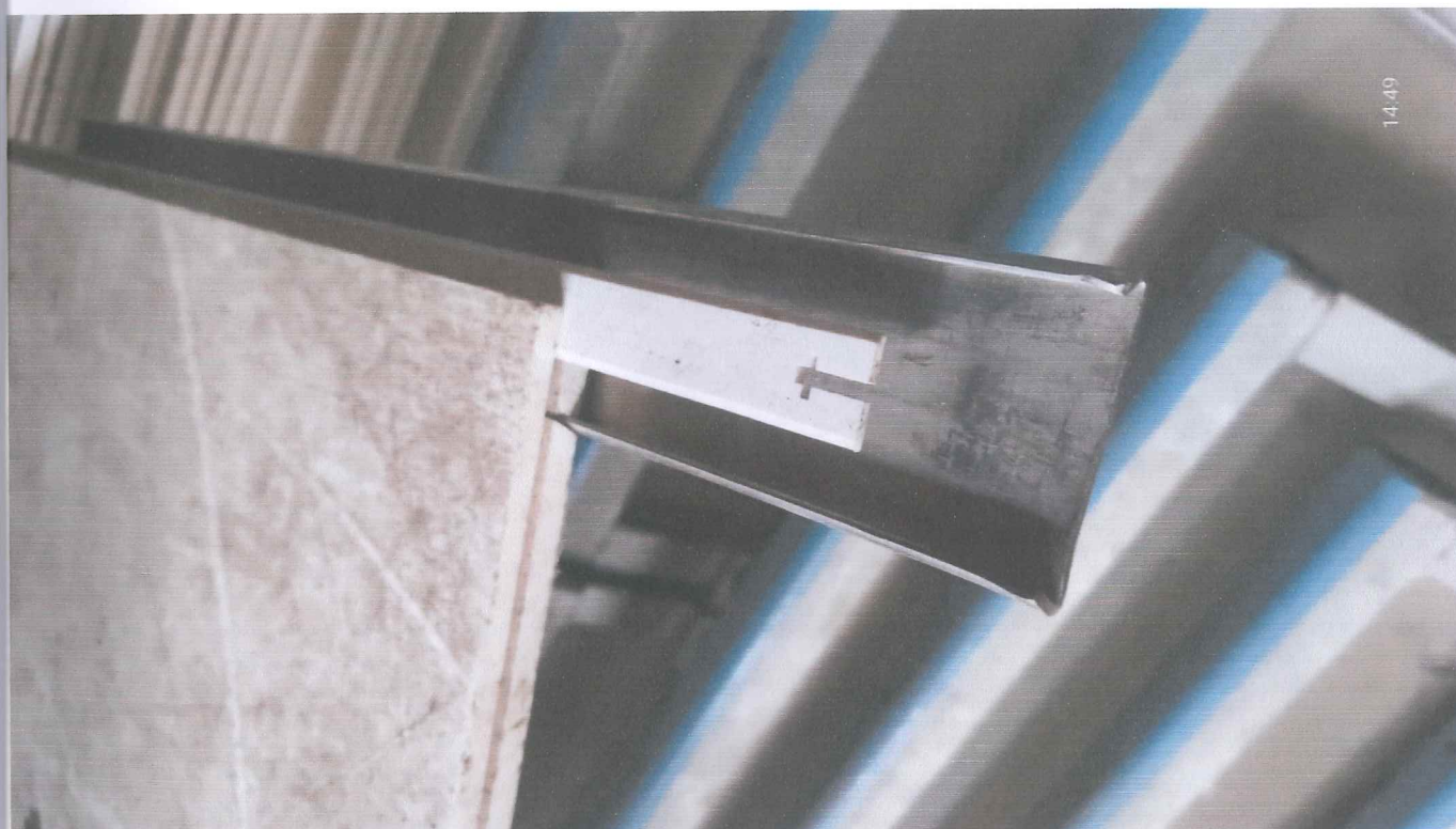
Panely a spojovací lišty, detail spoje pero - drážka
