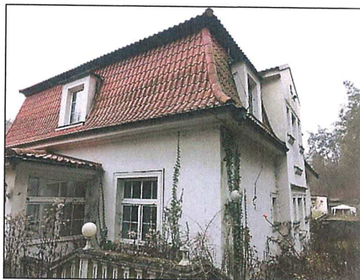
pohled z východu
