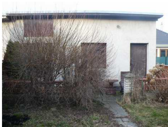
vedlejší stavba ve dvoře
