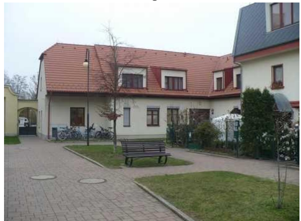
pohled na bytový dům z dvorního traktu
