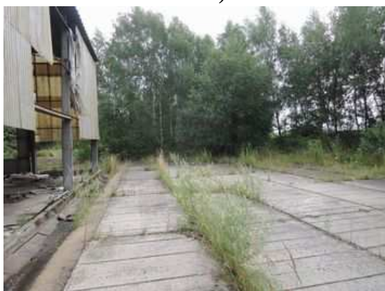
Zpevněné plocha podél jižní strany
