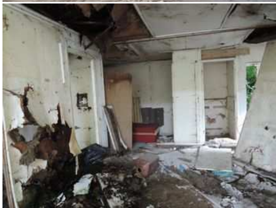
Přístavek na severní straně haly (montovaná buňka)
